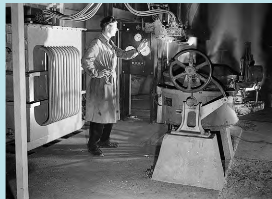
METALLURGI VAR EN AV SEKS AVDELINGER VED SINTEF I 1954. BILDET VISER SMELTEFORSØK I EN LYSBUE-STÅLOVN.
